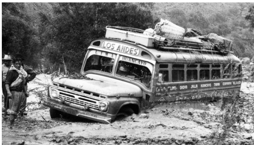
Strada centrale PE-22: ieri come oggi, è una delle vie di comunicazione più problematiche di tutto il Sudamerica.
